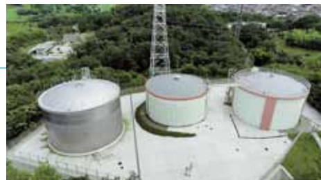
▲完成した低区第三配水池（左端）
