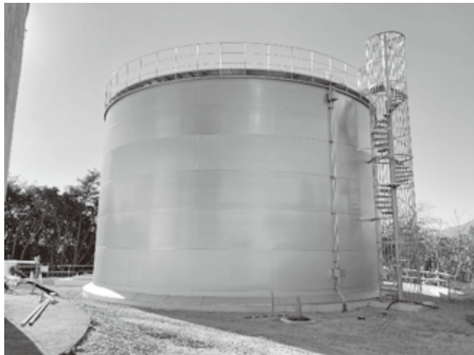
▼新しい配水池（低区第三配水池）
