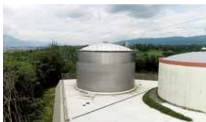
▲低区第3配水池
