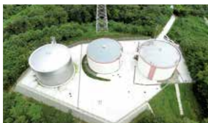
▲低区配水池上空写真
