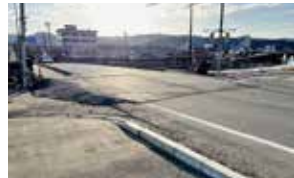
補修された橋の段差
