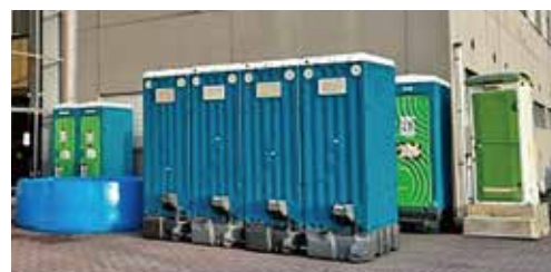
下水道が使用できないため設置された簡易トイレ
