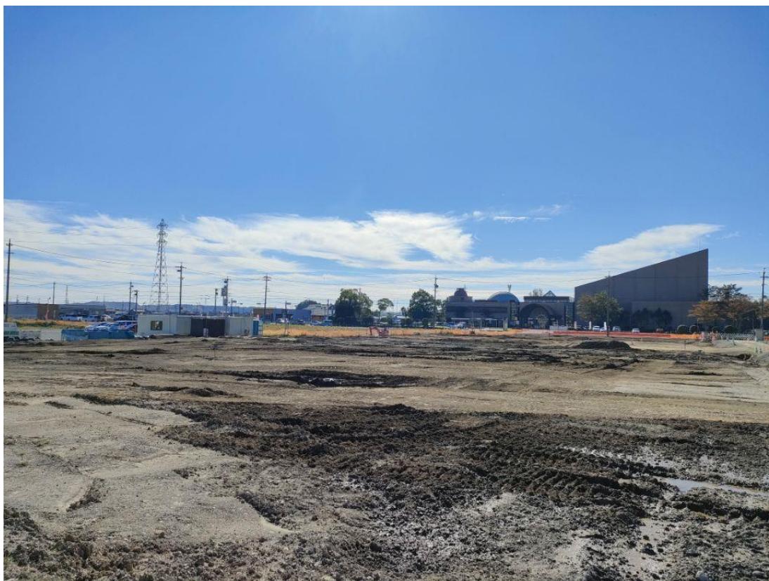
【敷地中央部】 造成工事状況（育苗研修交流施設解体撤去完了）
