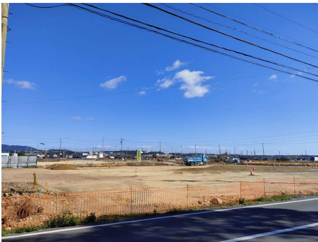
【敷地南西側】 造成工事状況（盛土工）
