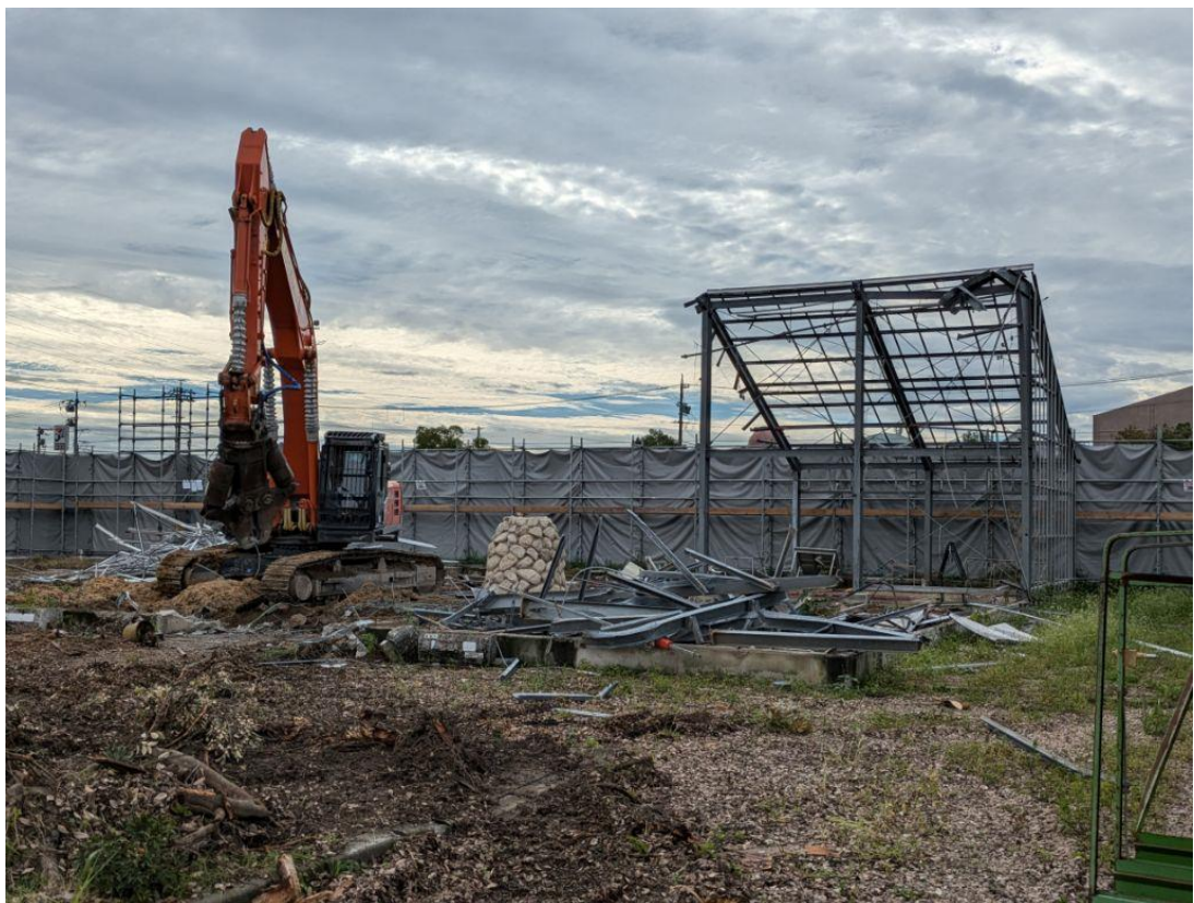
【敷地中央部】 造成工事状況（育苗研修交流施設解体撤去）
