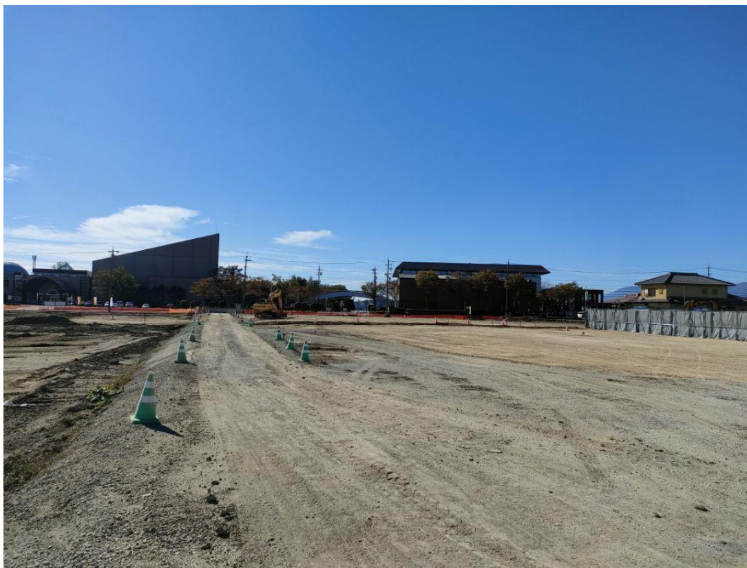
【敷地中央部】 造成工事状況（盛土工）
