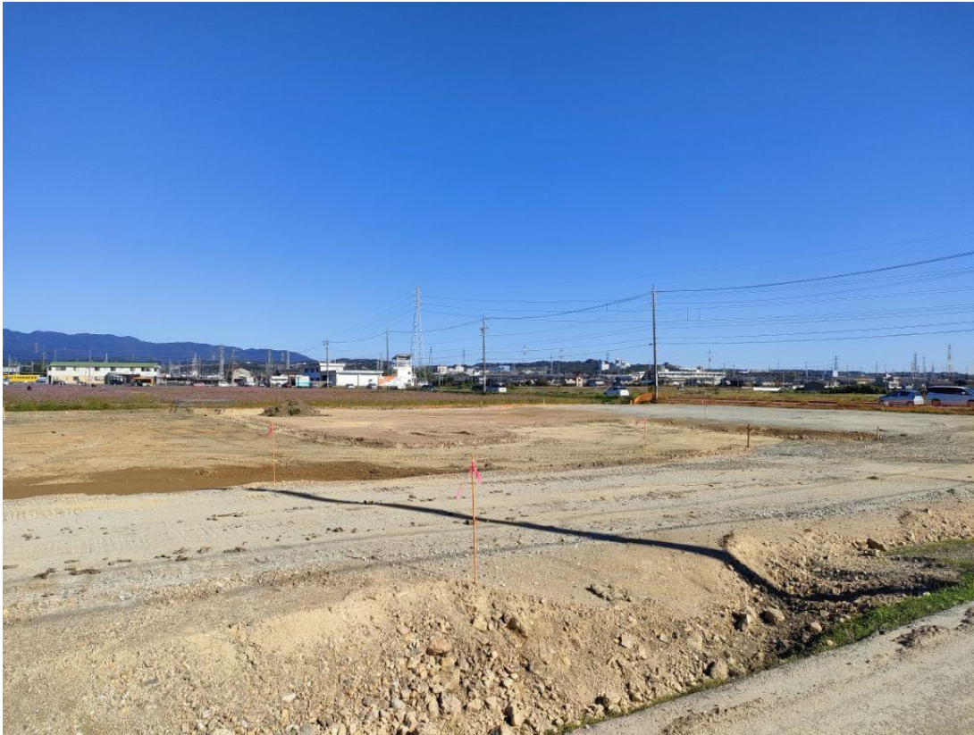
【敷地北東側】 造成工事状況（盛土工）
