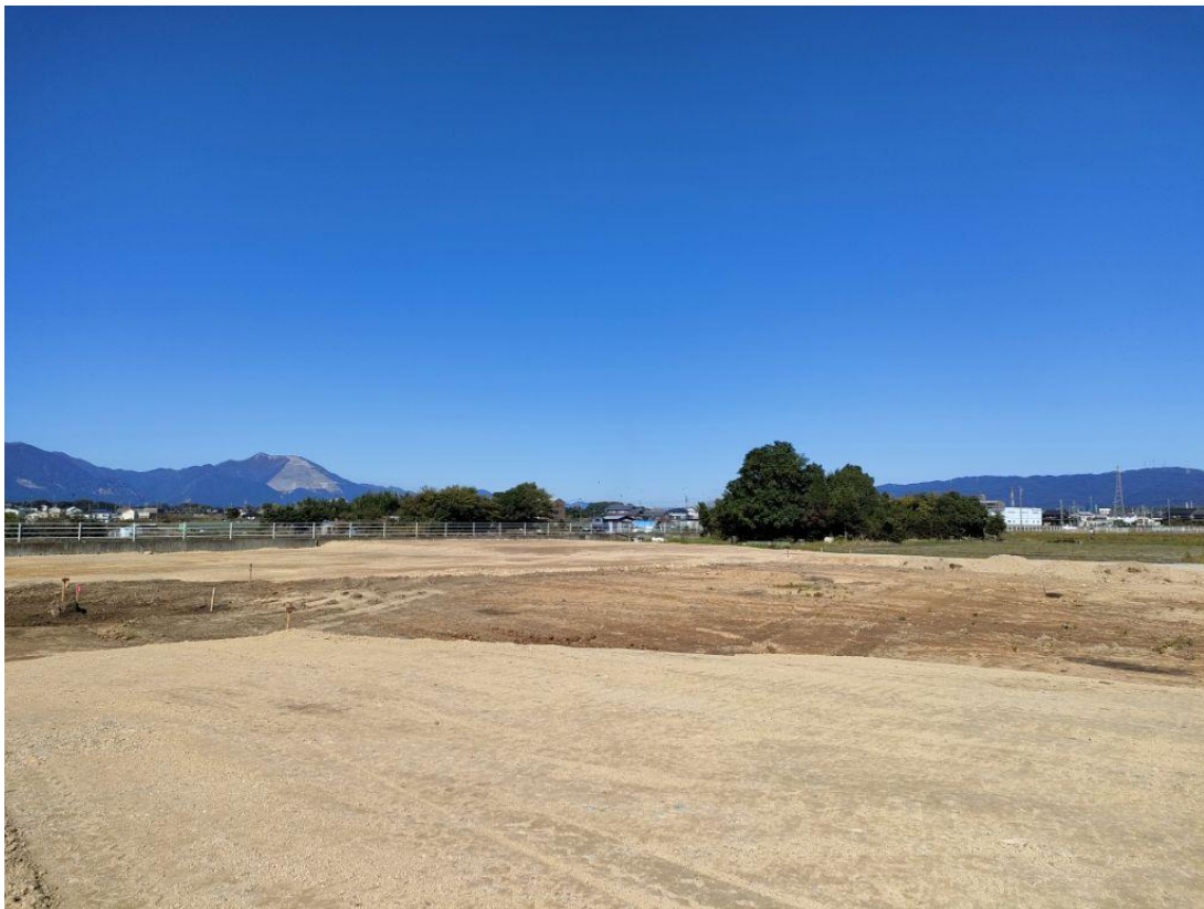
【敷地北西側】 造成工事状況（盛土工）
