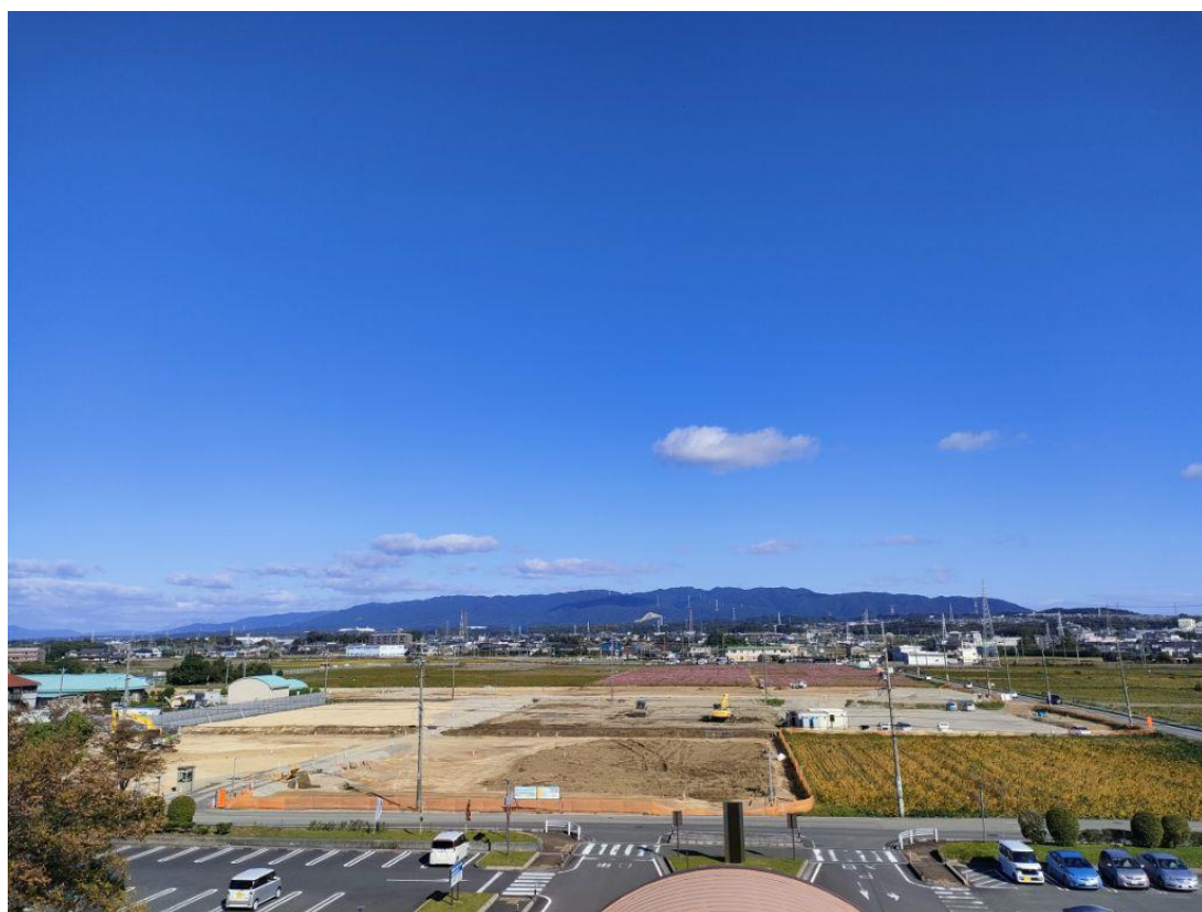
【敷地全景】 造成工事状況
