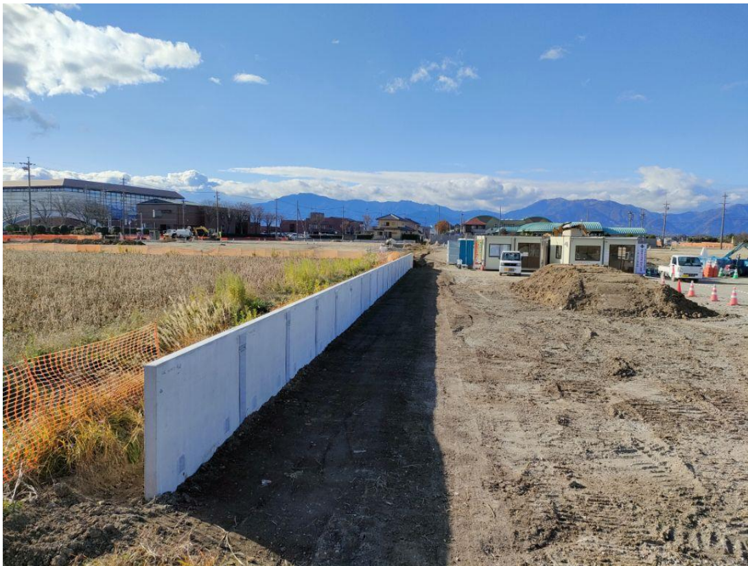
【敷地東側：テニスコート】 造成工事状況（L型擁壁工）
