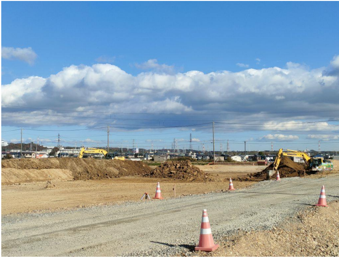
【敷地北東側：校舎】 造成工事状況（盛土工）
