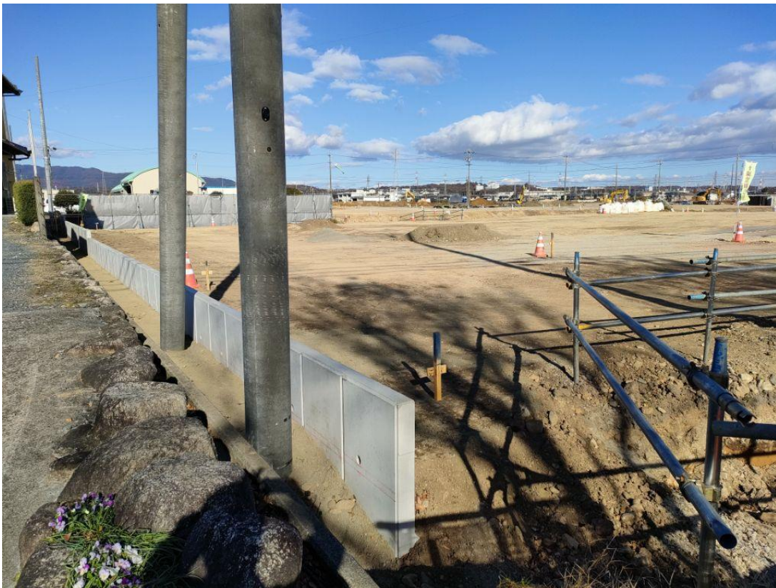
【敷地南西側：来客用駐車場】 造成工事状況（L型擁壁工）
