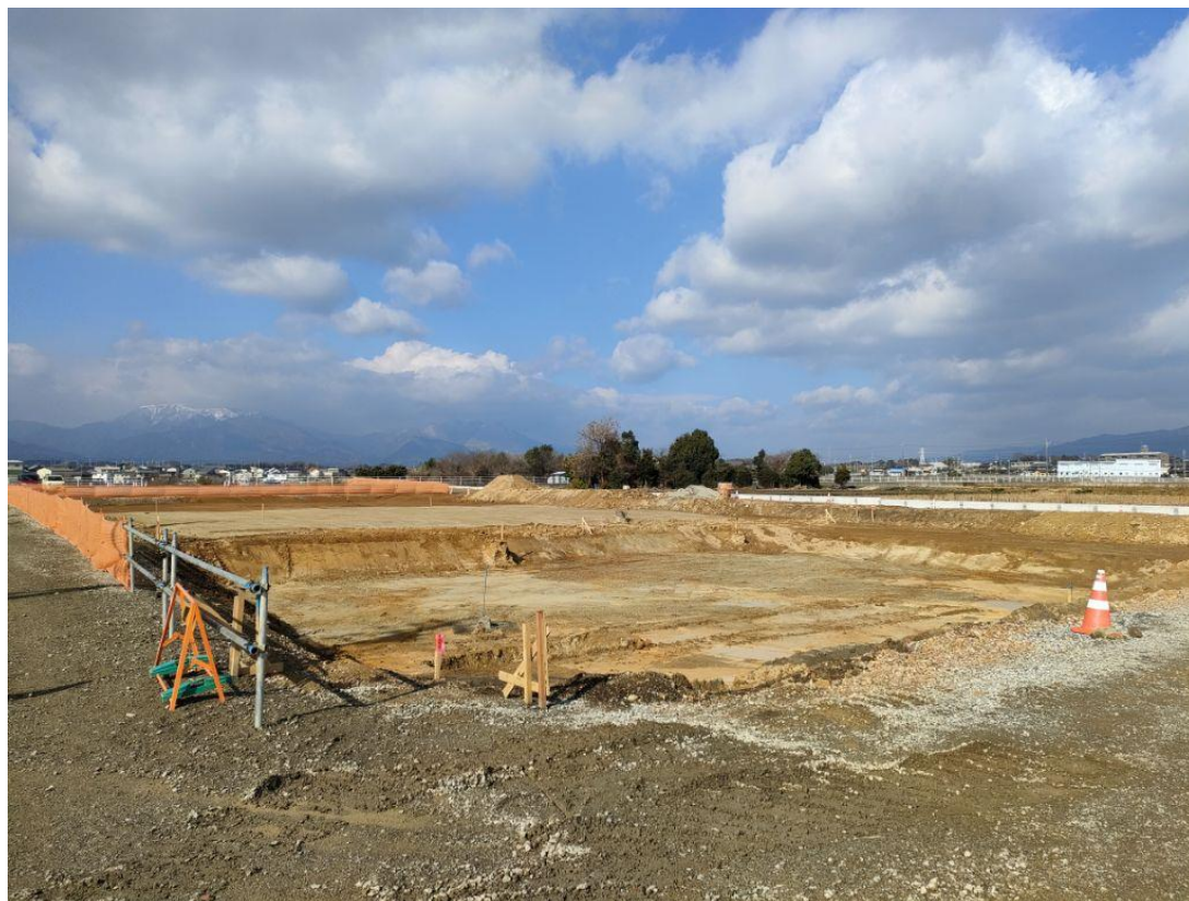
【敷地北西側：体育館建設場所】 造成工事状況
