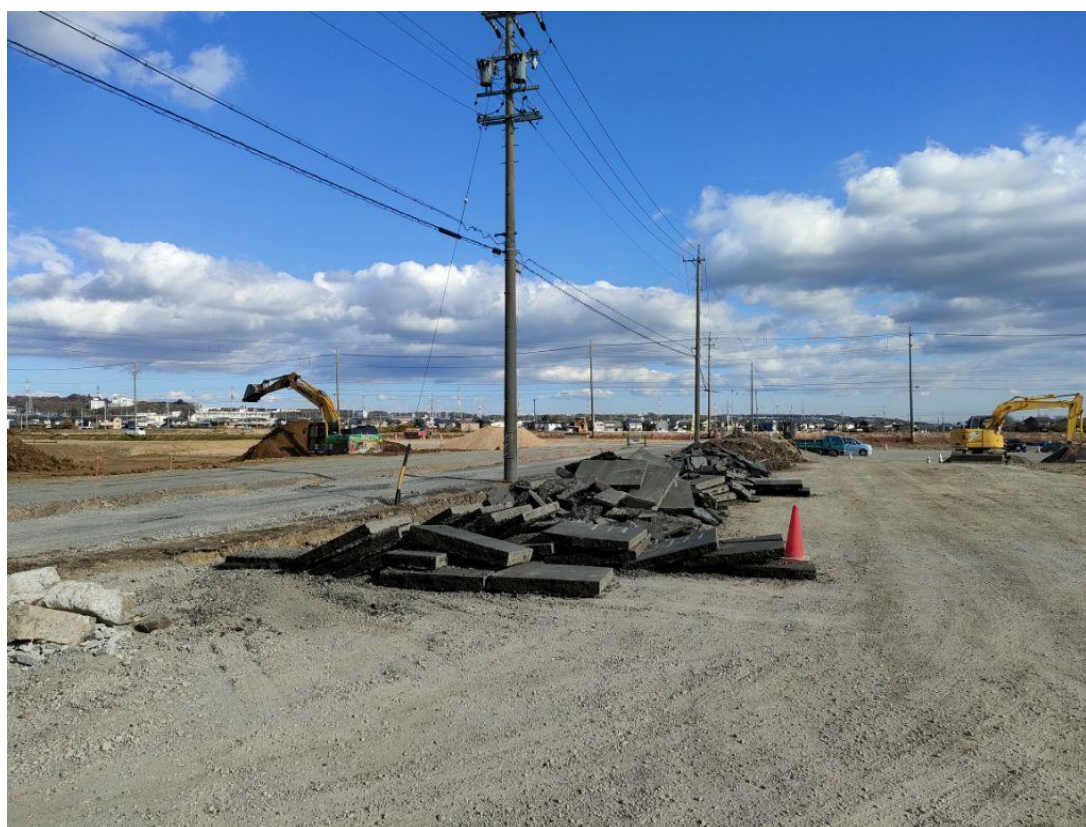
【敷地中央部】 造成工事状況（アスファルト撤去工）
