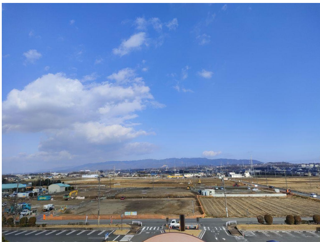
【敷地全景】 造成工事状況
