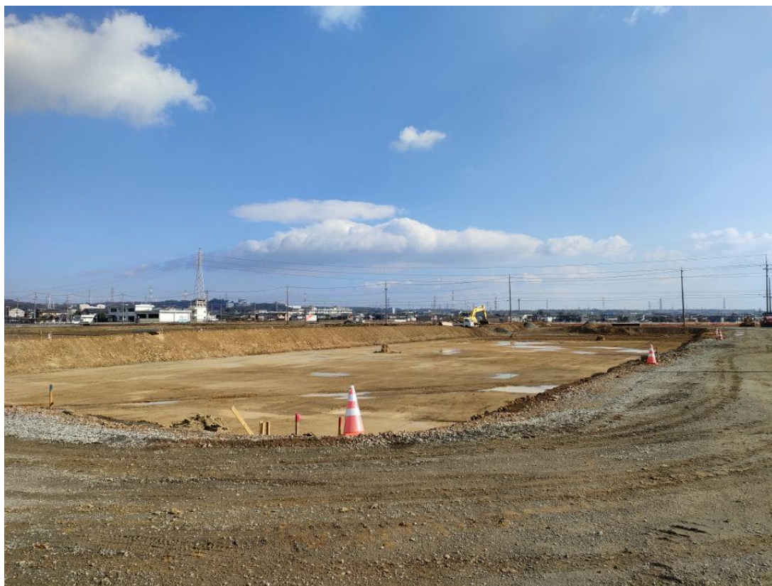
【敷地北東側：校舎建設場所】 造成工事状況
