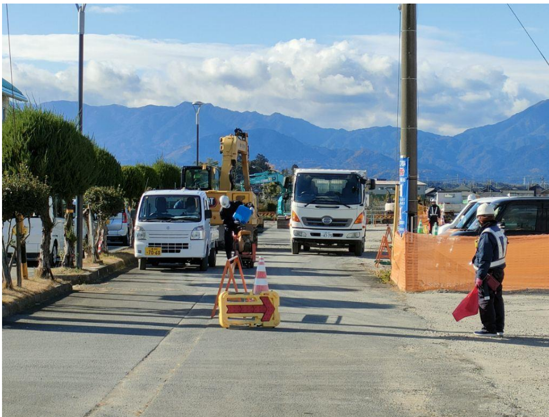
【敷地中央部】 造成工事状況（農水管撤去工）
