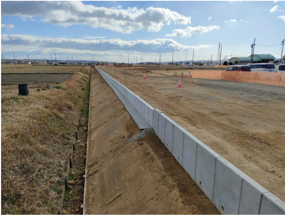
【敷地北側】 造成工事状況（L型擁壁工）
