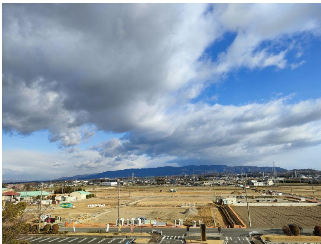
【敷地全景】 造成工事状況
