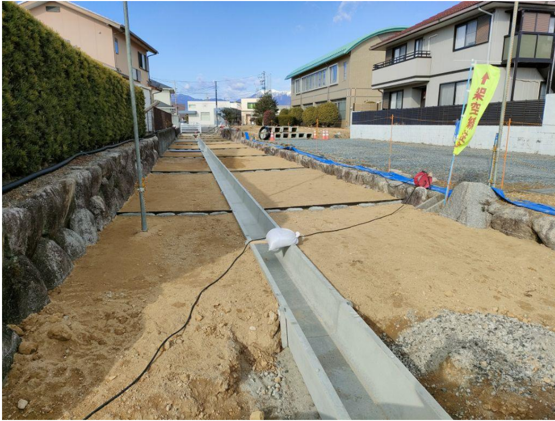
【敷地南西側】 造成工事状況（地区外排水工）
