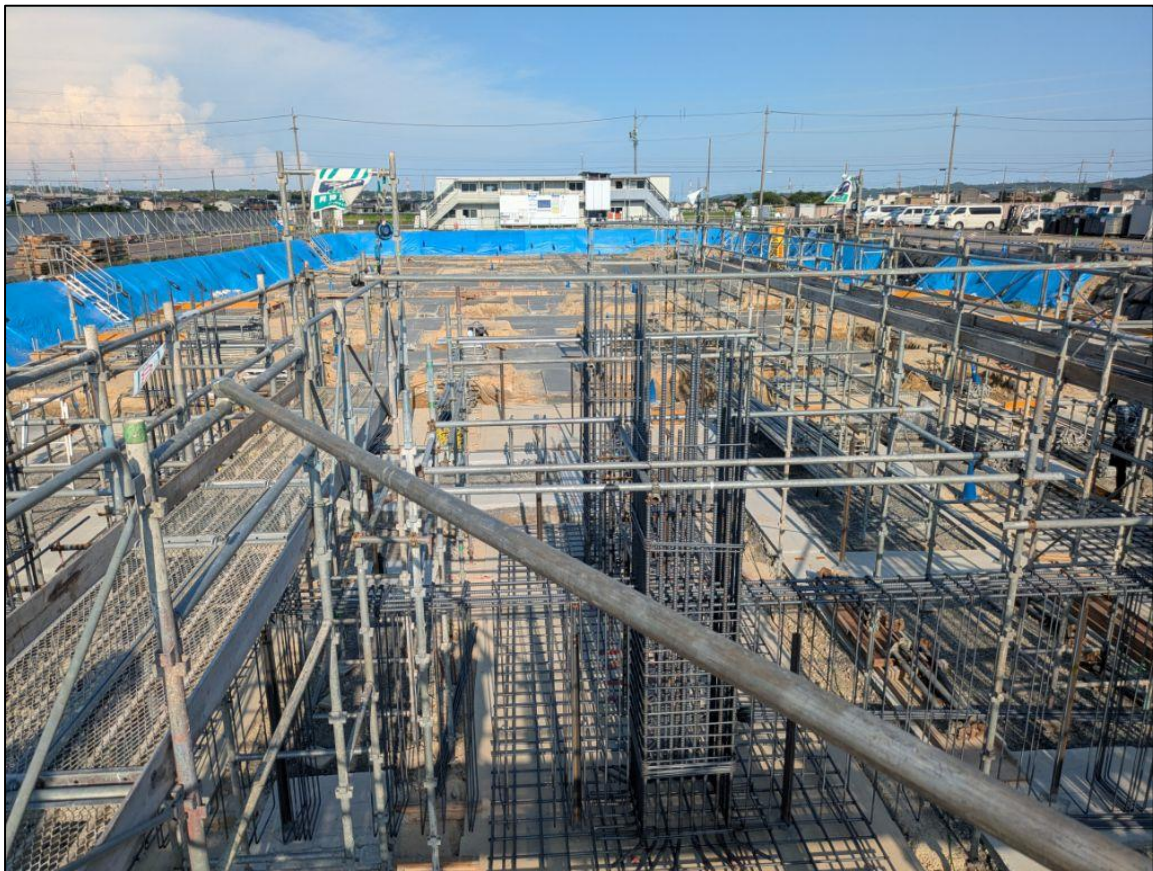
【敷地東側：校舎棟】 基礎部分の施工が進められています
