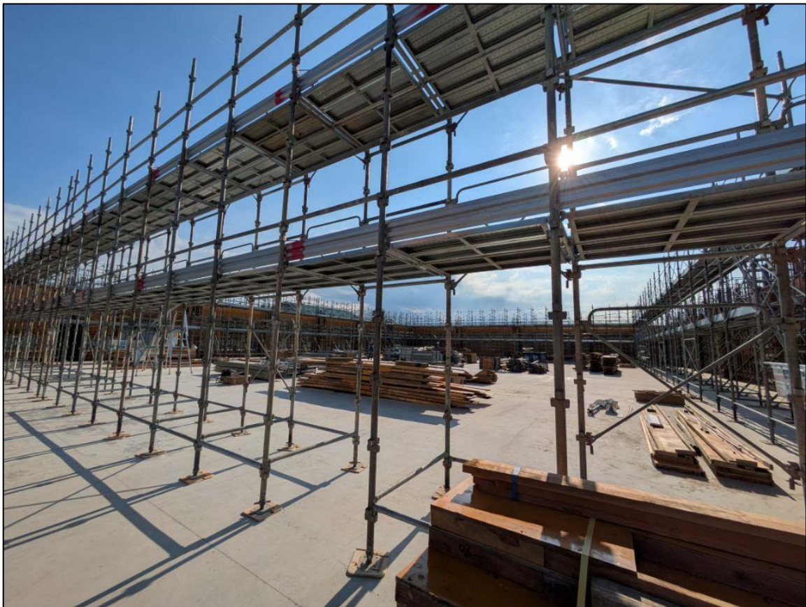
【敷地西側：体育館棟】 アリーナの壁に着手しています
