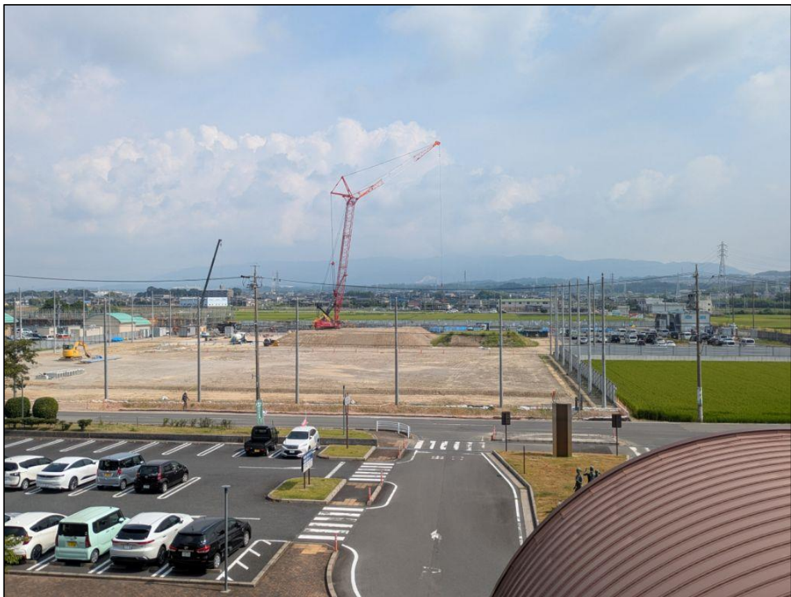
【敷地内】 総合文化センター屋上から
