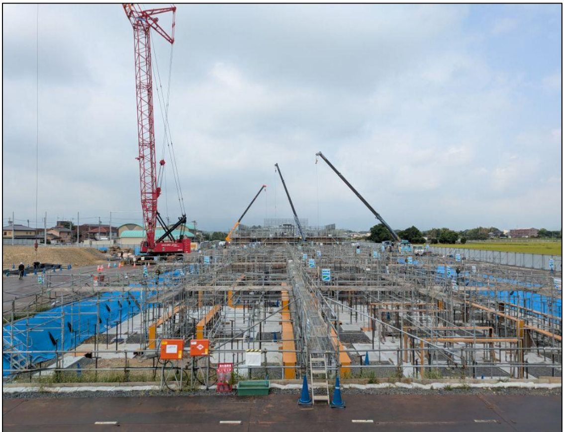
【敷地東側：校舎棟】 先月に引き続き、基礎部分の工事が進められています
