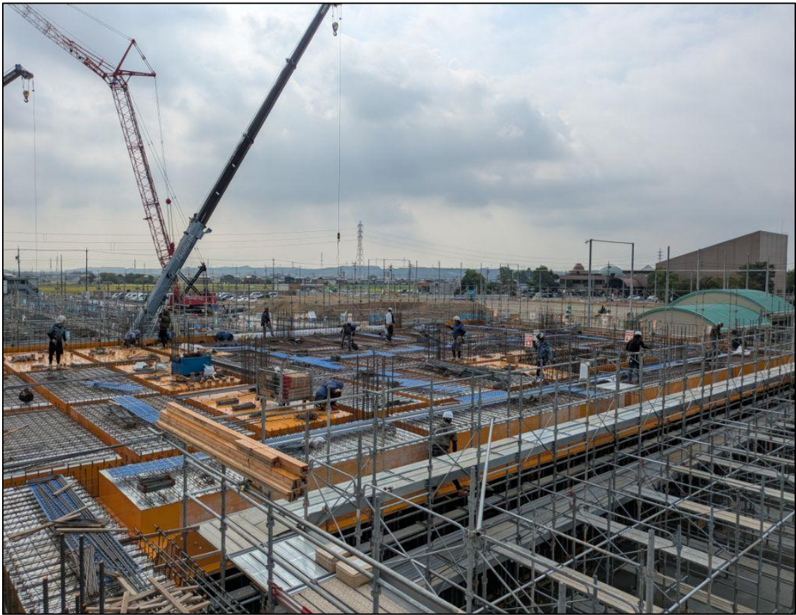
【敷地西側：体育館棟】 2階部分の床面の形が見えてきました
