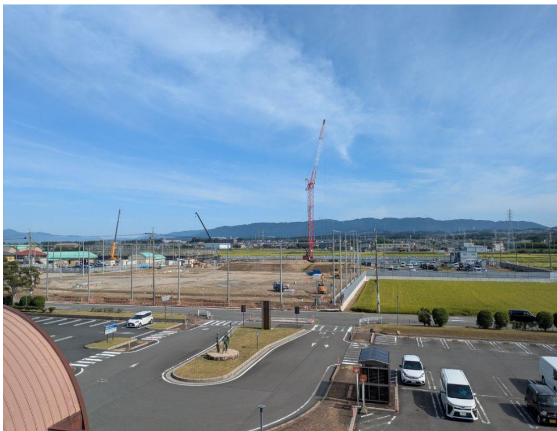
【敷地内】 総合文化センター屋上から
