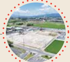
新東員第一中学校建設
