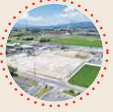
新東員第一中学校建設
