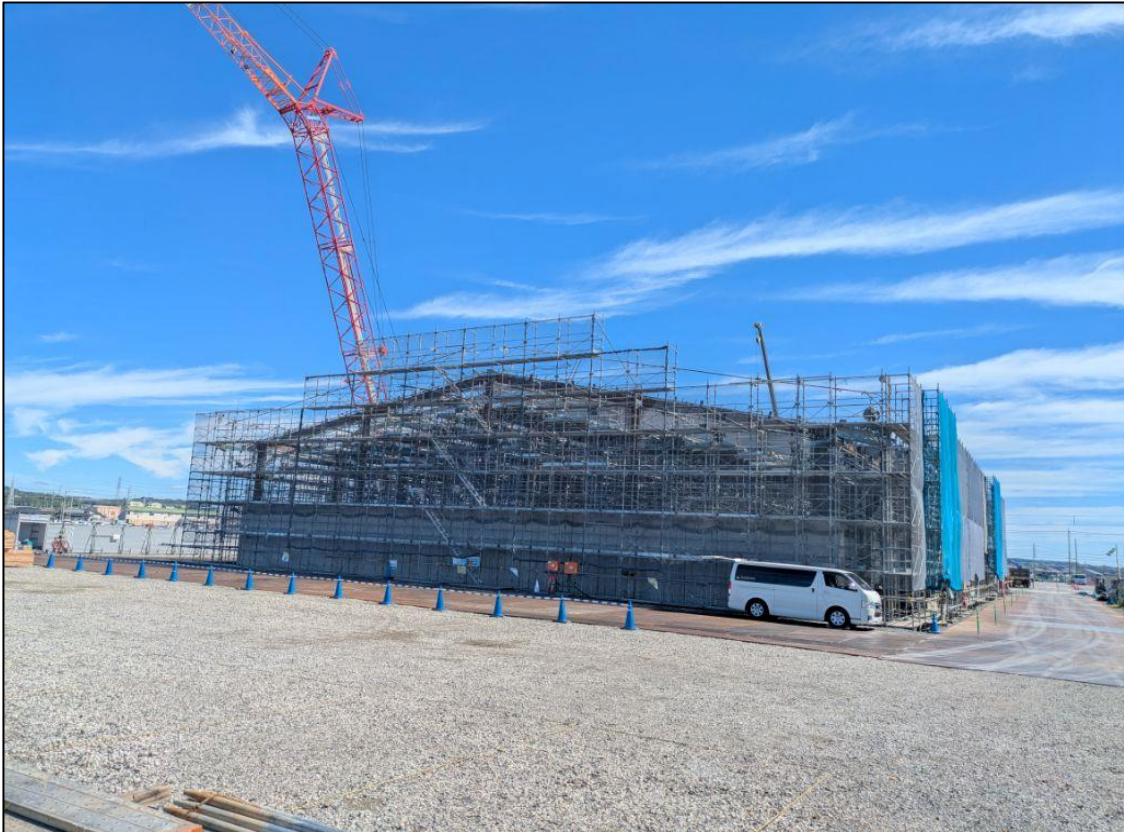
【敷地西側：体育館棟】 屋根の骨組みが出来て、全体の形が見えてきました
