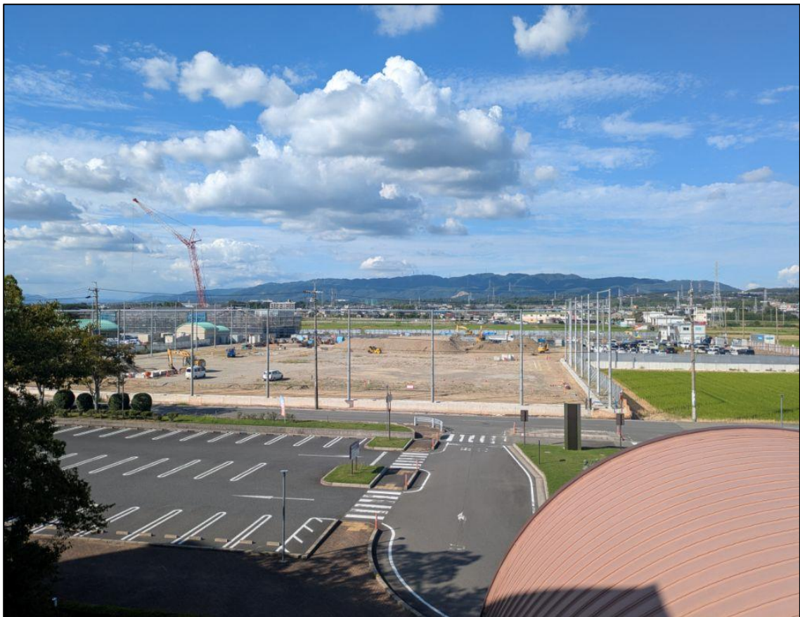
【敷地内】 総合文化センター屋上から
