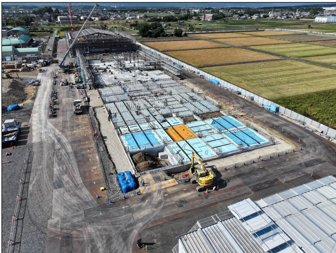
【敷地東側：校舎棟】
