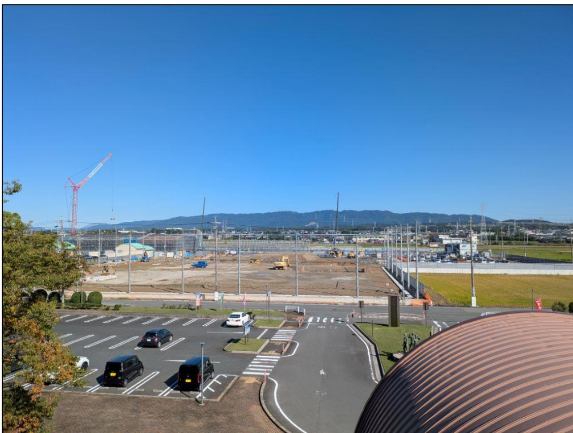
【敷地内】 総合文化センター屋上から
