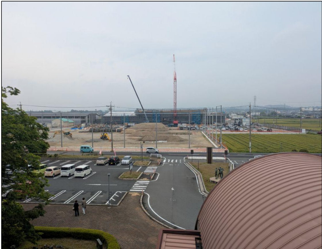
【敷地内】 総合文化センター屋上から
