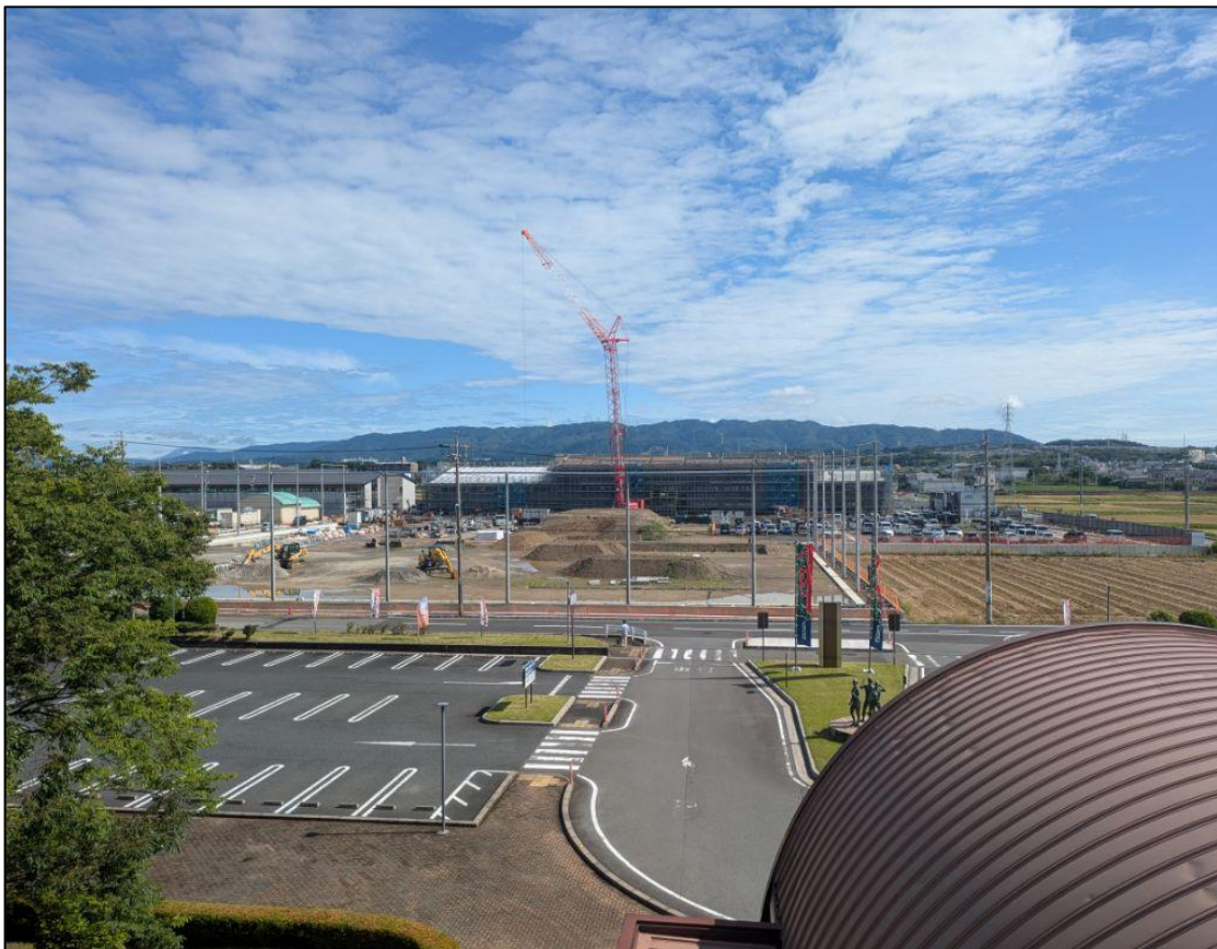
【敷地内】 総合文化センター屋上から
