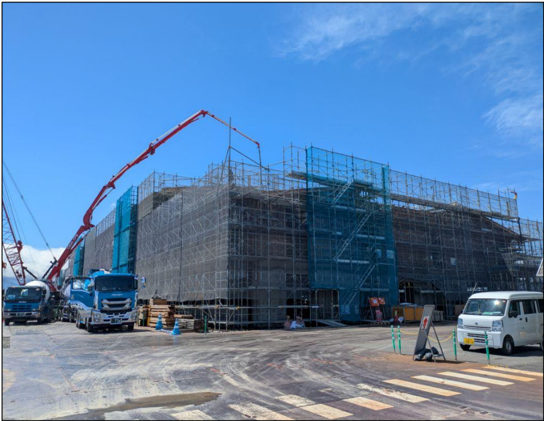
【校舎棟 東側外観】
