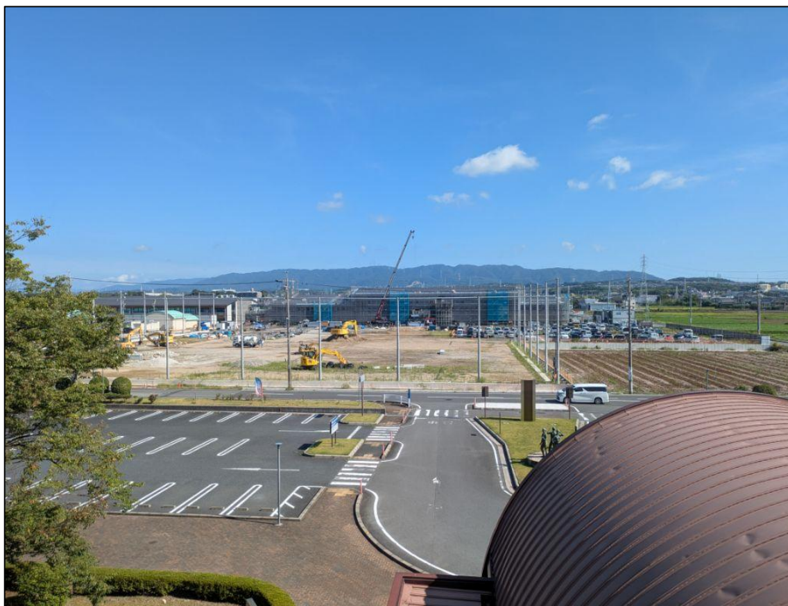
【敷地内】 総合文化センター屋上から
