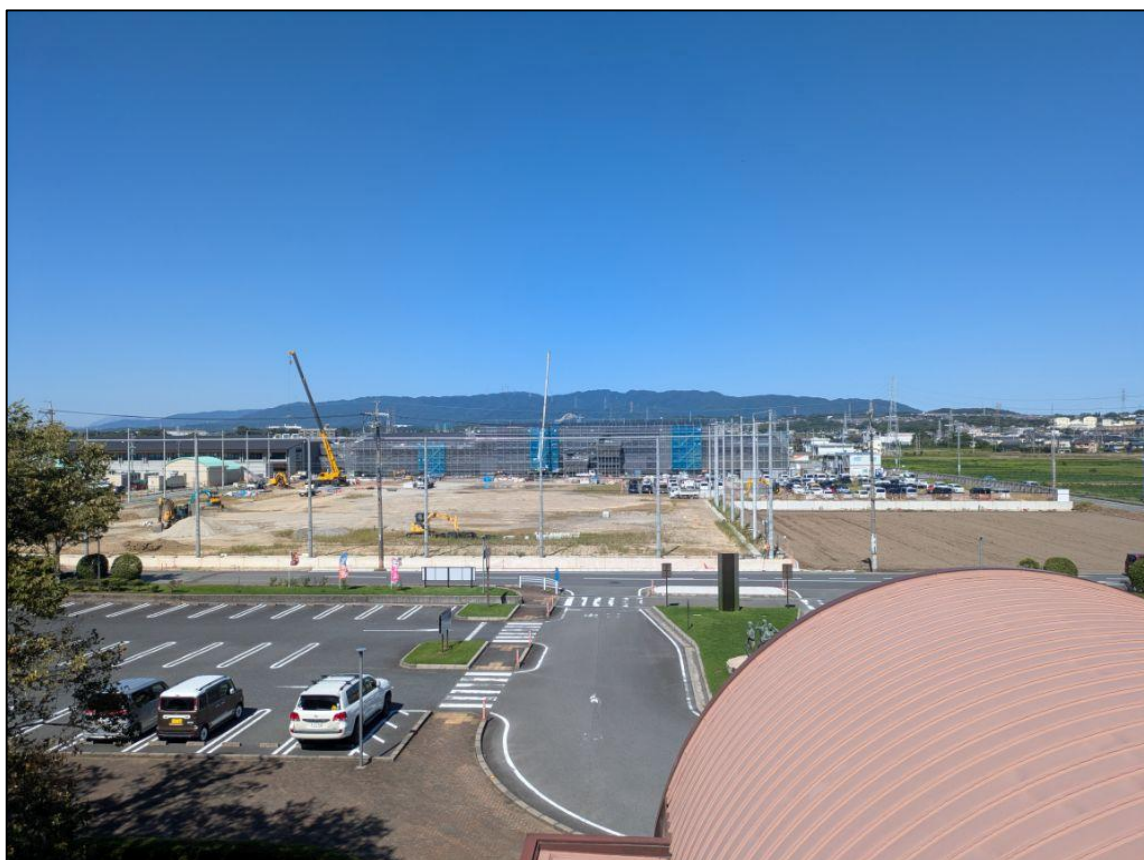
【敷地内】 総合文化センター屋上から
