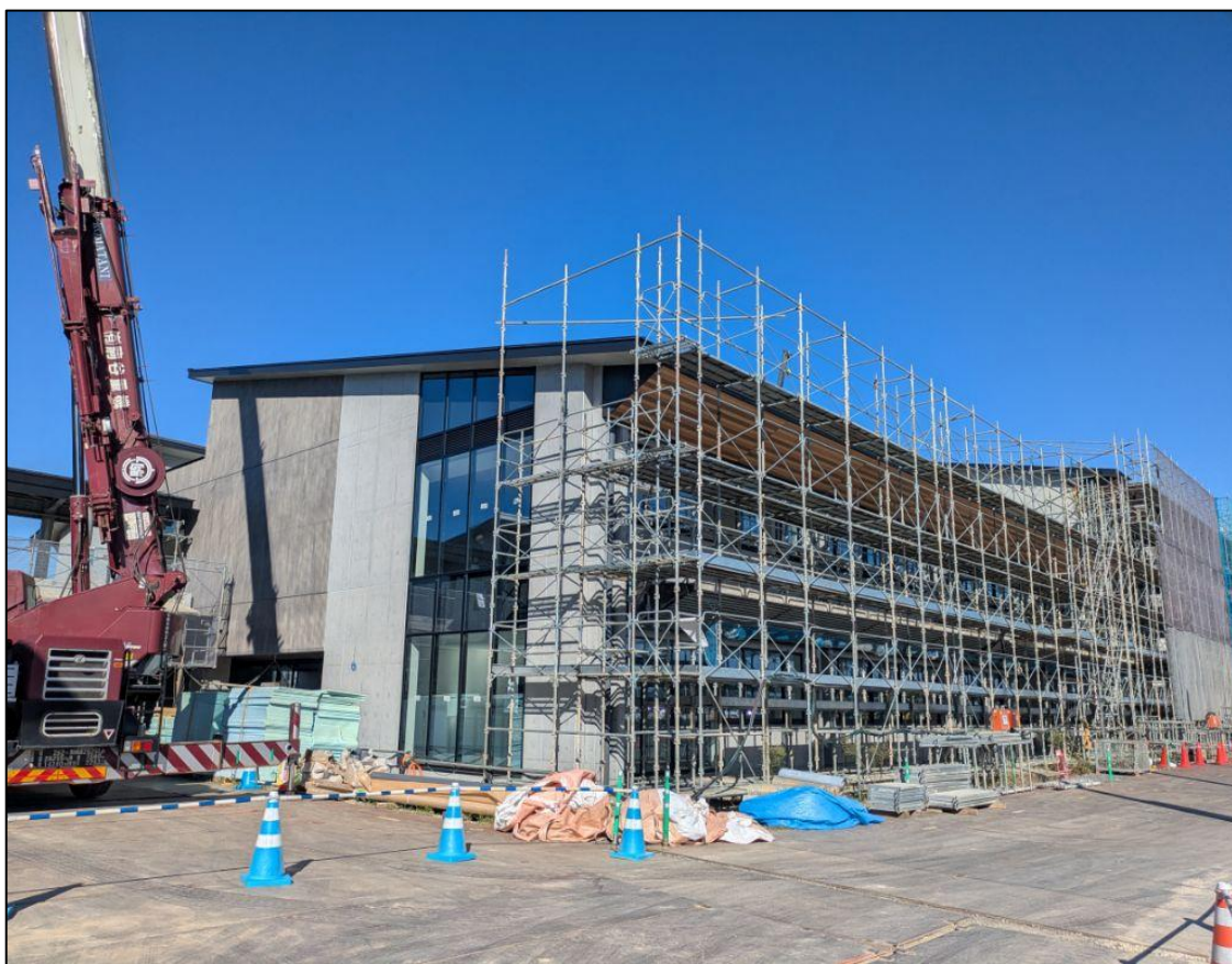
【敷地東側：校舎棟】
