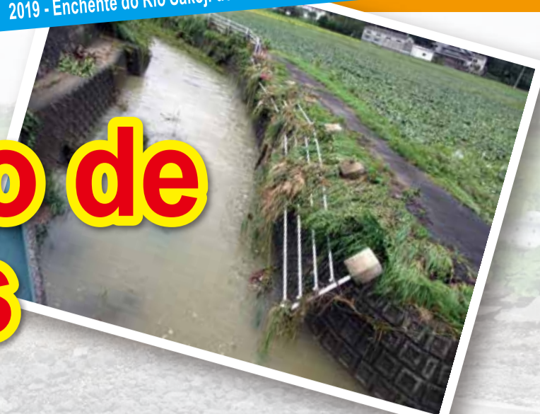
2019 - Enchente do Rio Sakoji devido às fortes chuvas
