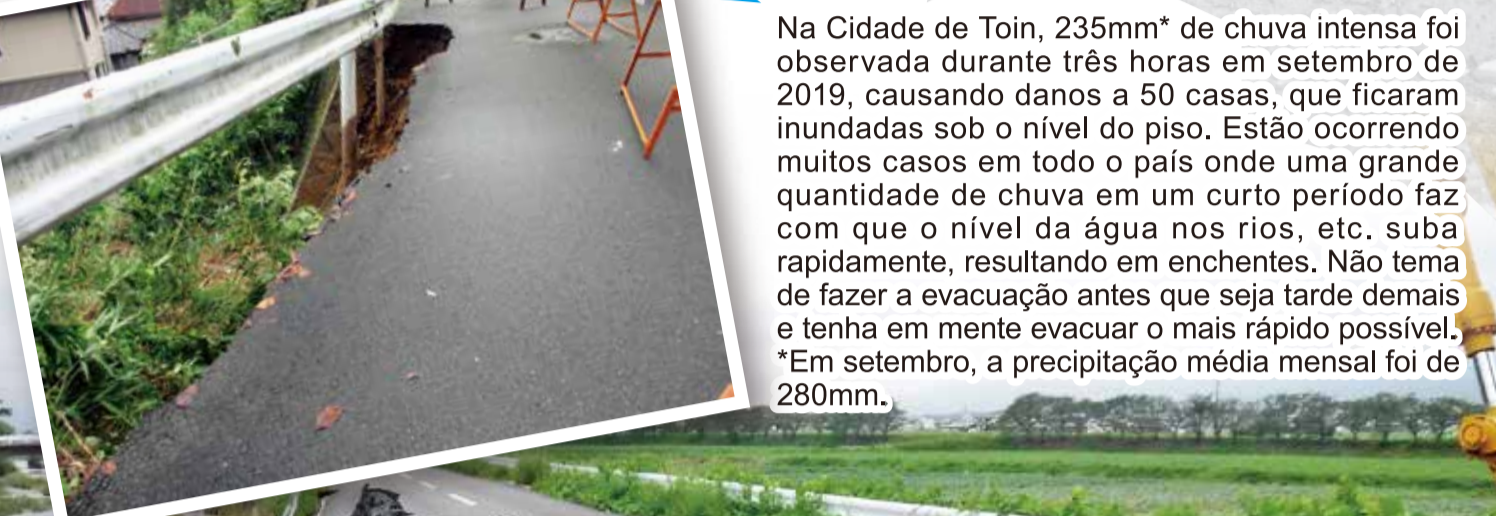
2019 - Desabamento de um barranco devido às fortes chuvas
