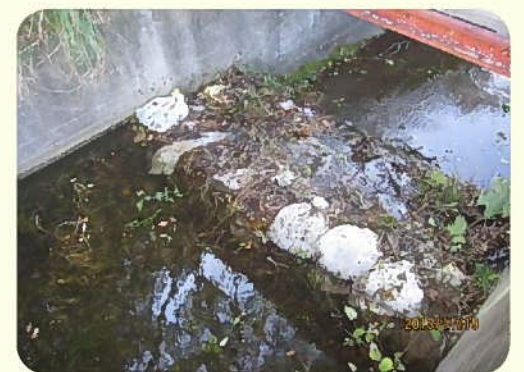
土のうによる洪水吐のかさ上げ
