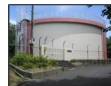
高区第2配水池
