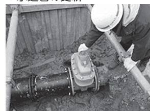
▼水道管の更新
