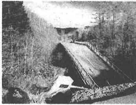
洞爺湖町_伏見橋崩落事故
