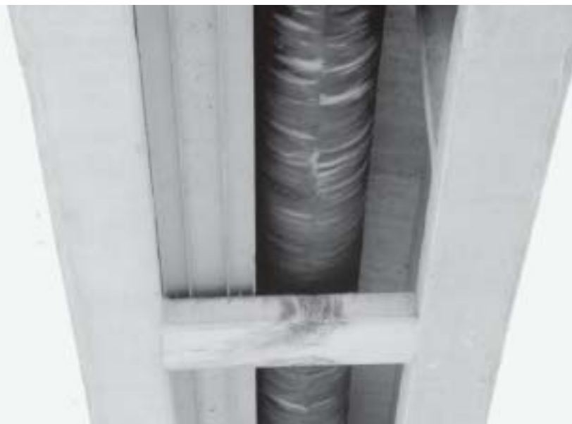
水神橋の裏に口径60cmの導水管が
