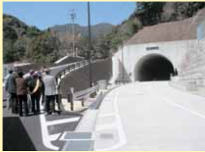
石樽トンネル (三重県側)
