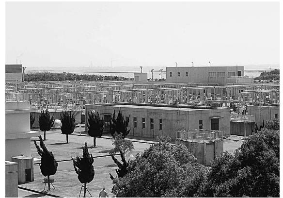
川越町にある公共下水処理場
