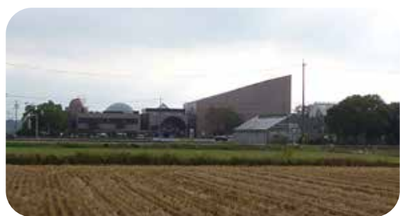
新第一中学校の建設用地
