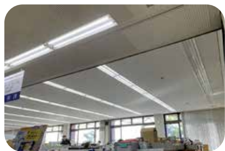
役場内のLED照明
