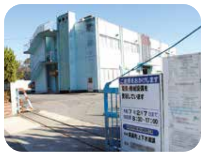
施設更新中の上水道管理事務所
