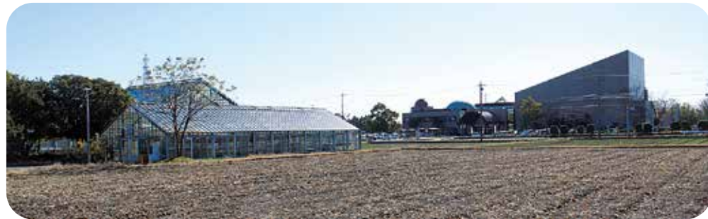
総合文化センターに隣接した建設予定地
