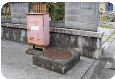
撤去する防火水槽
