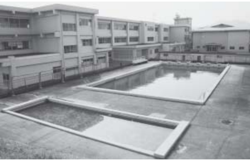
改修がまたれる笹尾西小プール
