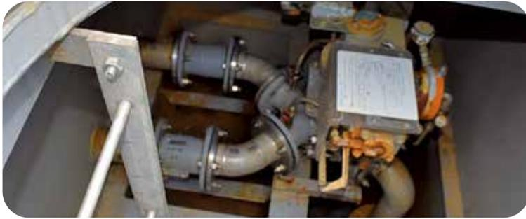
耐震性貯水槽の緊急遮断弁
