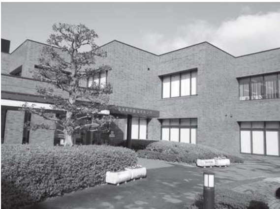
施設が古くなってきました
