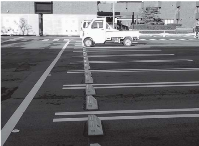
車止めが追加工事とは
