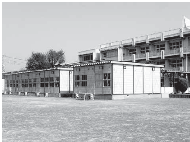
生徒増に対応した神田小学校仮設校舎
