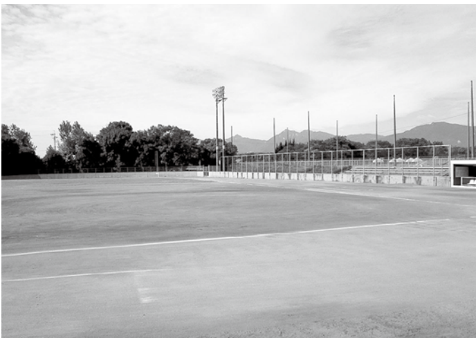
設備が古くなってきました
