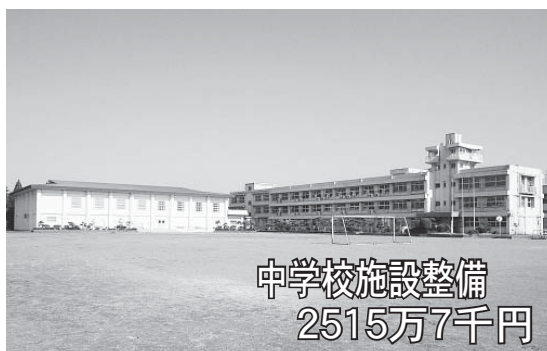
築50年経過した第一中学校南校舎
