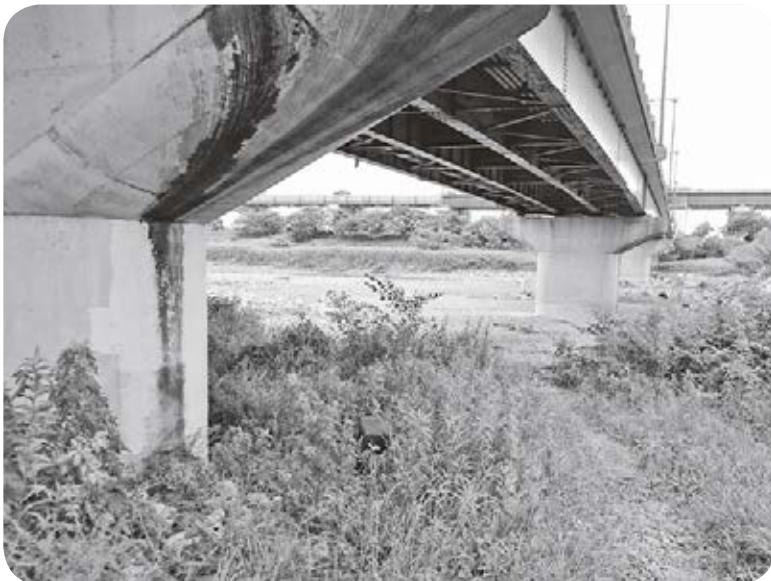
大社橋左岸の現状
