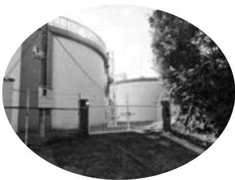
新たに配水池の建設予定
