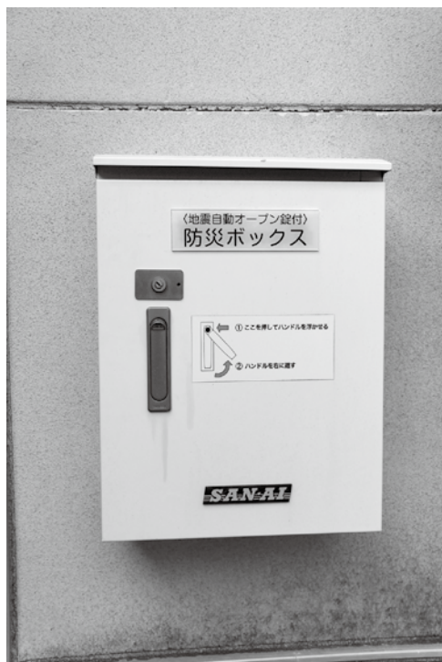
震災時に開く鍵ボックス
