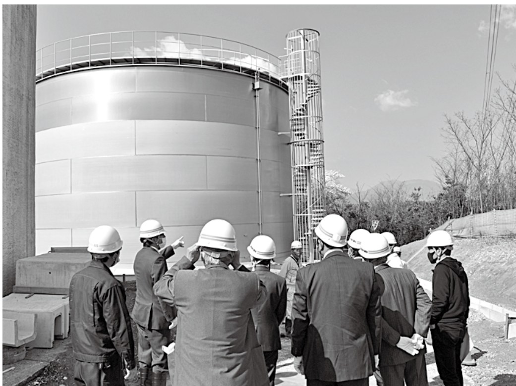
増設工事中のタンクを視察
