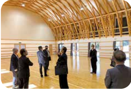
在来工法を基本にした木造ホール棟
