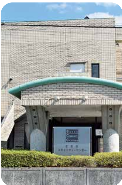
そろそろ改修時期が来ました
