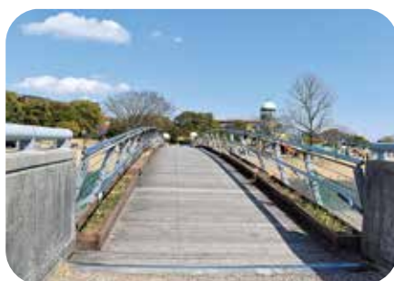
長寿命化対策で安全確保
