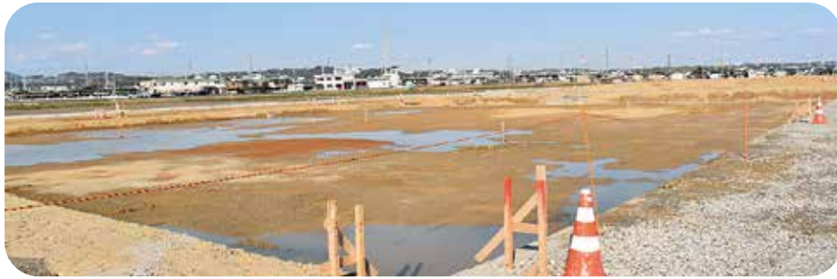
4月から校舎建設始まります
