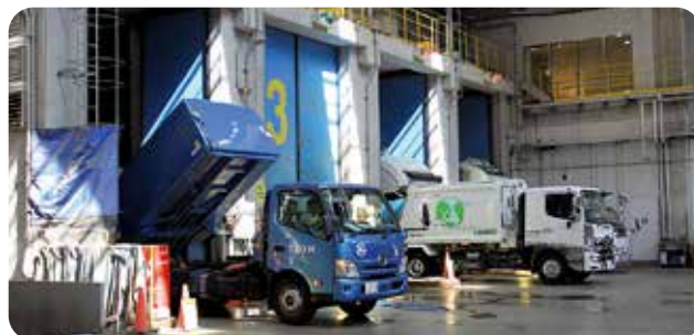
可燃ごみ搬入ピット
