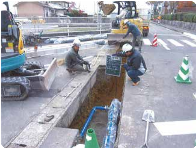
管路更新工事
