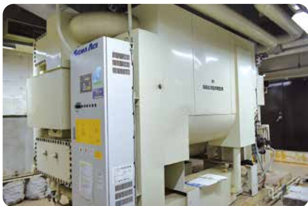
吸収式冷温水発生機の改修
