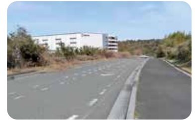
一部供用を開始している道路
